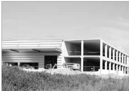
Firma Daniševský s.r.o. – stavba nové provozní haly v oblasti Průmyslové zóny Poliřka
