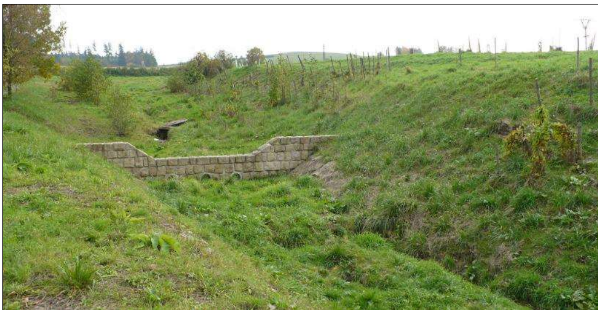
Betonová přehrážka na výrazné údolnici nad zástavbou v Lichnově (zdroj: P. Pavka)
