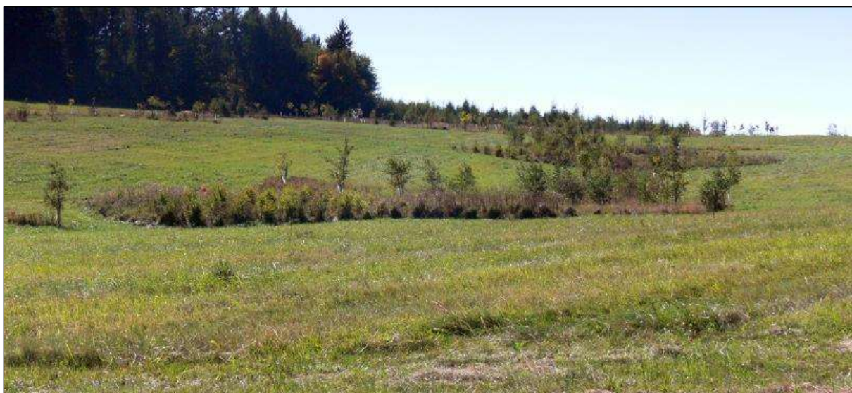
Systém hrázek s ozeleněním a tůňkami na zatravněné údolnici v Brodku u Konice (zdroj: P. Pavka)
