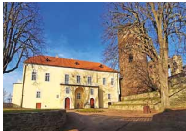
Nová úprava hradního nádvoří
