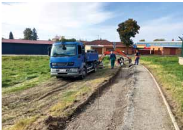
Stavební úpravy chodníku na Sídliště Hegerova
