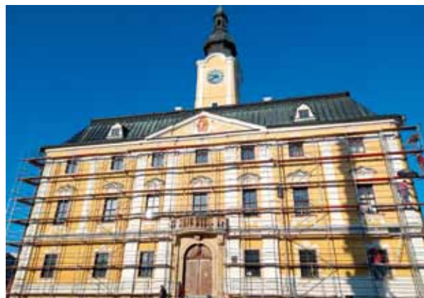
Obnova pláště radnice
