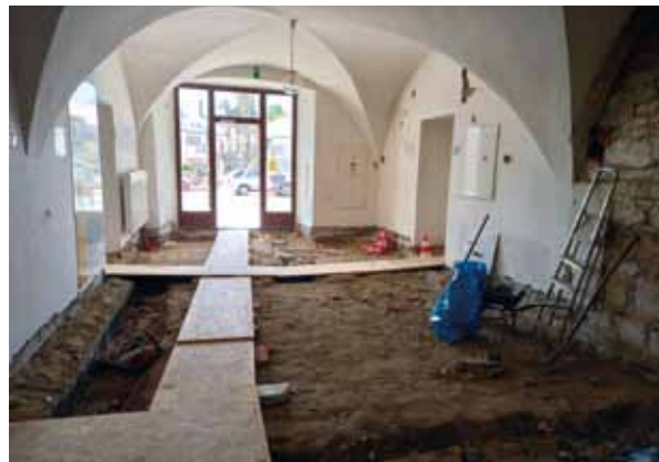
Rekonstrukce MěÚ Polička
